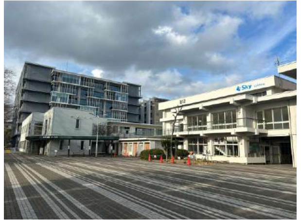
食堂があるB12棟と、工学部のB7棟
